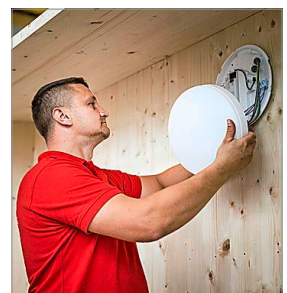
Vitalii Smoltc hilft beim Innenausbau der Wohncontainer.
